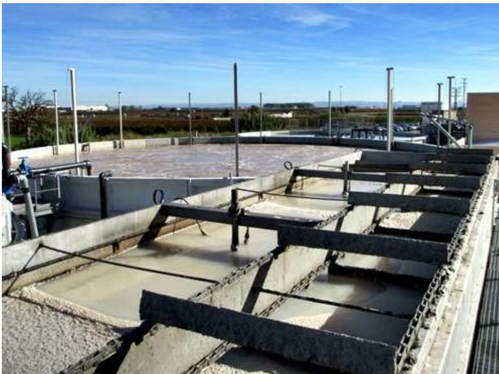
Las instalaciones de pre tratamiento existentes, que se han aprovechado en la nueva instalación, comprendían un desbaste de sólidos, una balsa de homogeneización aireada de tamaño insuficiente para tener una retención de 24 horas y un flotador CAF.
