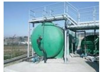
Depósitos de alimentación y Reactor Biológico, con sistema de aireación
