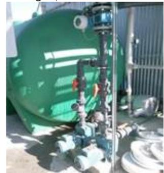
Detalle del bombeo de alimentación a Reactor SBR
